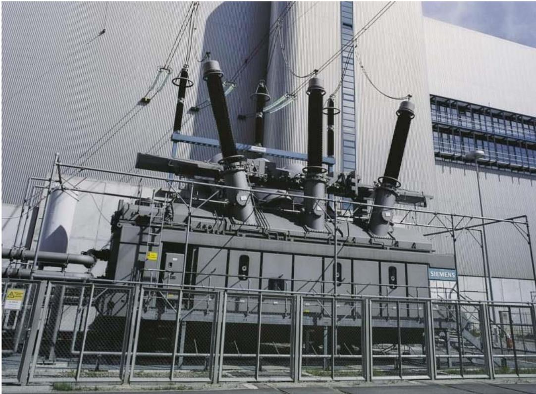
**Bild 2.20: Blocktransformator** im Braunkohle-Kraftwerk "Schwarze Pumpe", Deutschland: 27 kV / 380 kV, 800 MVA, Kühlung OFAF. Die vom Kraftwerksblock (Dampfkessel, Turbine und Synchron-Turbo-Generator) erzeugte elektrische Leistung 800 MVA mit der Spannung 27 kV wird über den Transformator auf 400 kV hochgespannt. Durch den umgekehrt proportional heruntertransformierten kleinen Strom entstehen nur geringe Stromwärmeverluste auf der Freileitung (Siemens AG).
