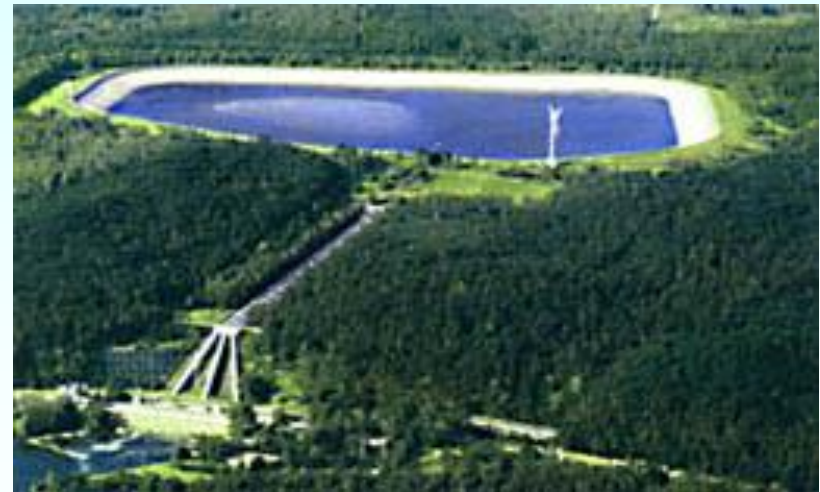
Pumpspeicherwerk Geesthacht bei Hamburg
