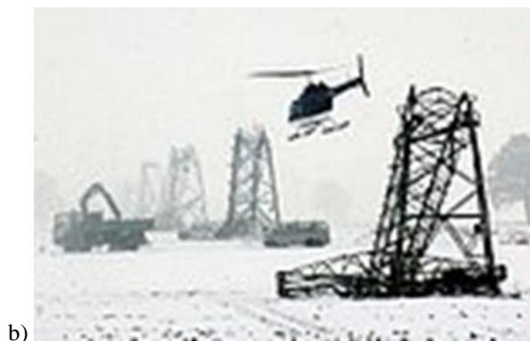
Bild V4.3-5: Freileitungsschäden an Gittermasten durch hohe Eis- bzw. Schneelast:
