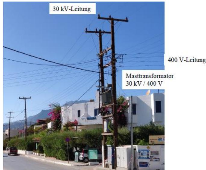
Bild V4.1-2: Spannungsversorgung in Südost-Kreta, Gemeinde Makri Gialos, Griechenland. Masttransformator-Station transformiert die  $3 \times 30$  kV auf die Ortsnetzspannung  $3 \times 400$  V (Quelle: J. Binder).
