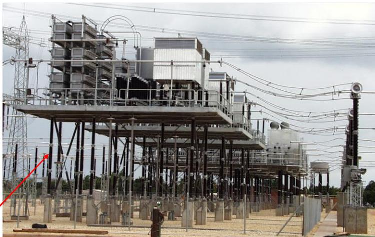
Bild V4.4-18: Serienkondensator-Schaltung/Phase  $C_K$  mit Hochspannungs-Schutzbeschaltung in einer langen 735-kV-Leitung, 60 Hz, *Kanada* (Quelle: Siemens, Hydro Québec).
