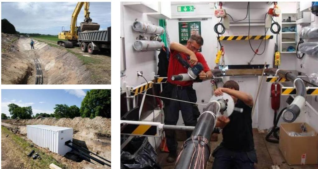
**Bild V4.4-22:** Landkabelverlegung mit Muffeninstallation im Montagecontainer (*Quelle: Wikipedia.de*).
