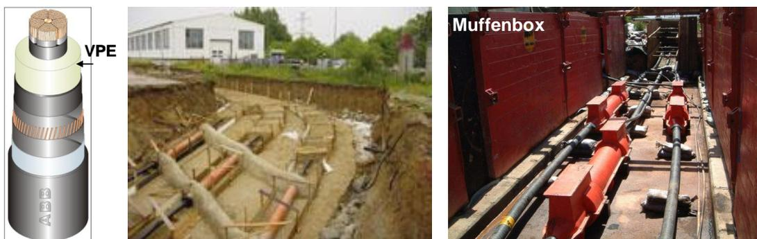
**Bild V4.4-23:** Hochspannungs-Drehstrom-Einleiterkabel 400 kV, 1000 MVA: Links: Schematischer Kabelaufbau einer VPE-isolierten Phase; Mitte: Erdverlegte Kabel R, S, T an einer Stelle, wo die Kabelschirme aus EMV-Gründen gekreuzt sind; rechts: Kabelmuffen in Muffenboxen in einem Kabelkanal (*Quelle: Wikipedia.de*).
