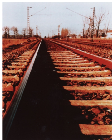
Gleis Emmerich - Wesel km 54,0
