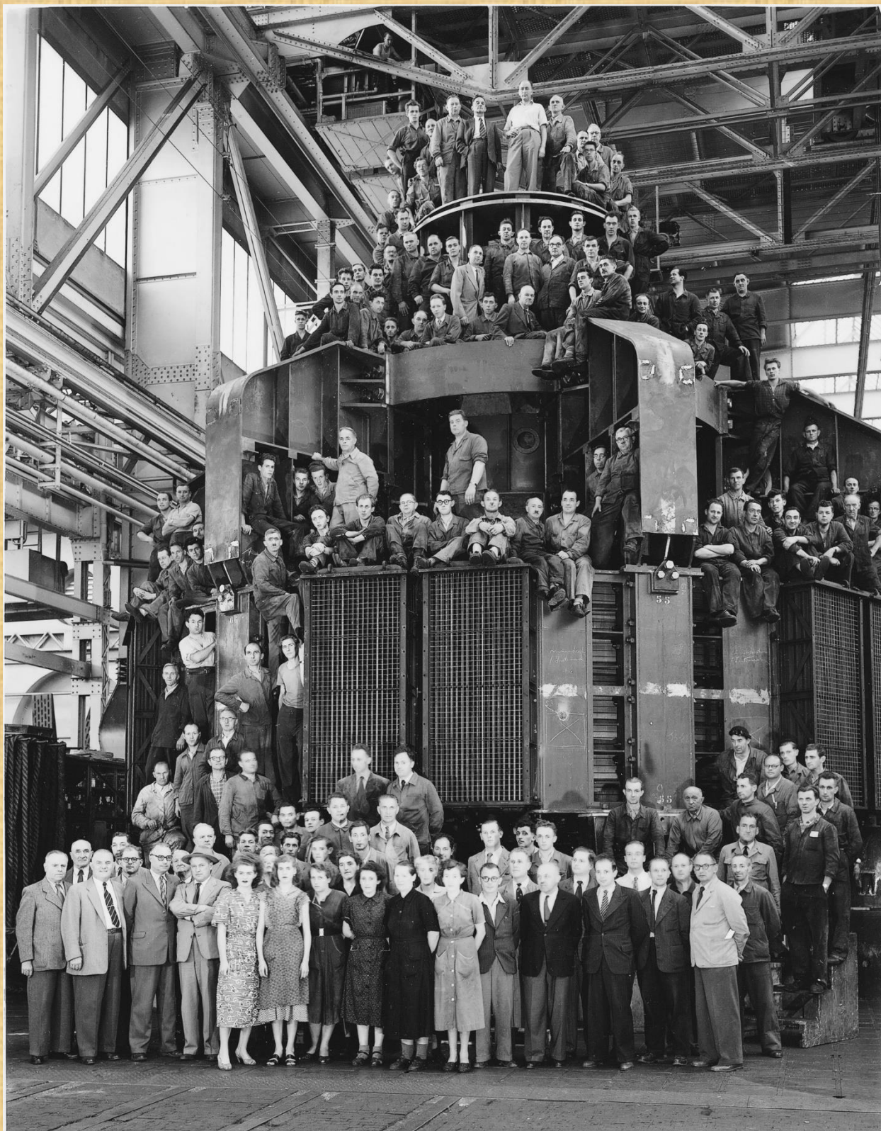
Aufstellung Hydrogenerator-Stator Assuan in der Grossmontagehalle Baden 1952 (Gruppenbild ohne E. Wiedemann)
