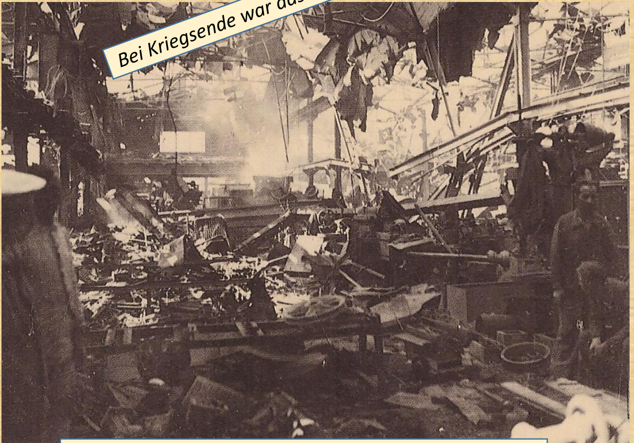
Zerstörte Stanzereihalle BBC Werk Mannheim-Käfertal
